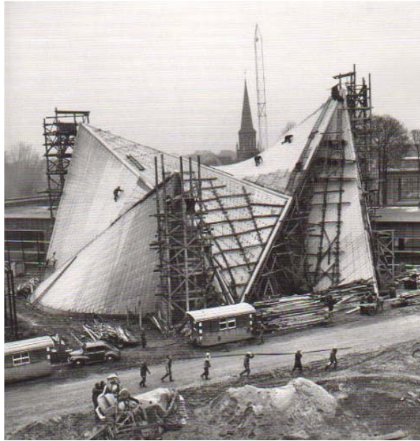
Fig.3 Proceso constructivo del Pabellón
