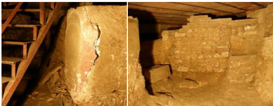
Fotografía 3: Restos de estucos rojizos de época romana. Visita realizada el 14 de noviembre del 2014.
