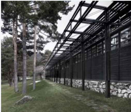
Visión lateral del edificio.
