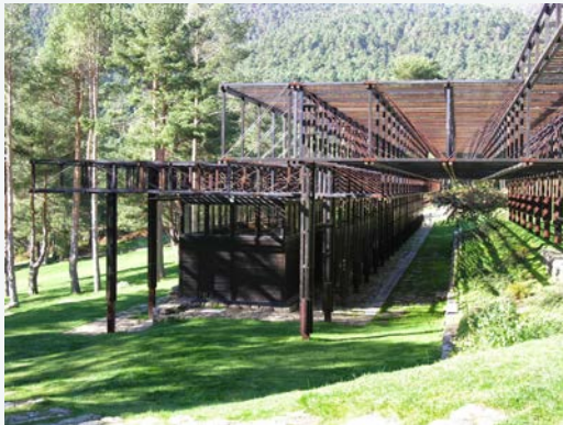
Visión transversal del edificio
