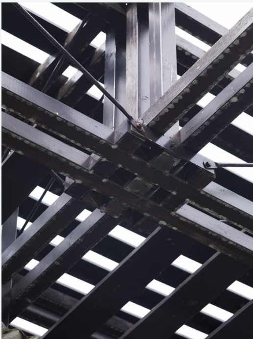
Detalle del nudo de la estructura.
