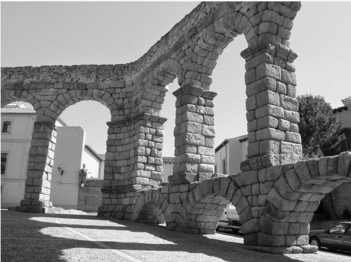
*Ilustración 2. Arcos del acueducto de Segovia. Donde se pueden apreciar las dovelas que conforman el arco de fábrica.*
