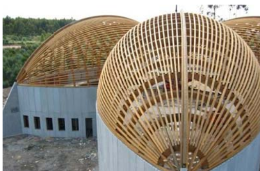
Fig. 9: Ejemplo de estructura de MLE.
