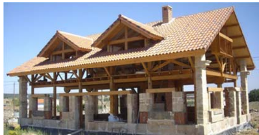
Fig. 6: Ejemplo de autoconstrucción, fase previa a cerramiento de balas de paja.
