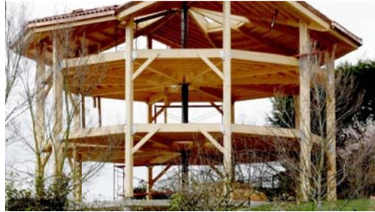
Fig. 5: Ejemplo de estructura entramada de madera.
