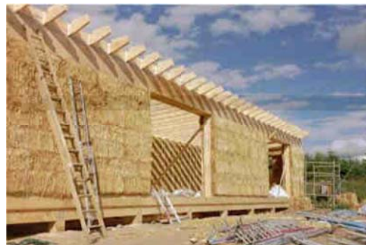
Fig. 2: Muros de carga a base de balas de paja.
