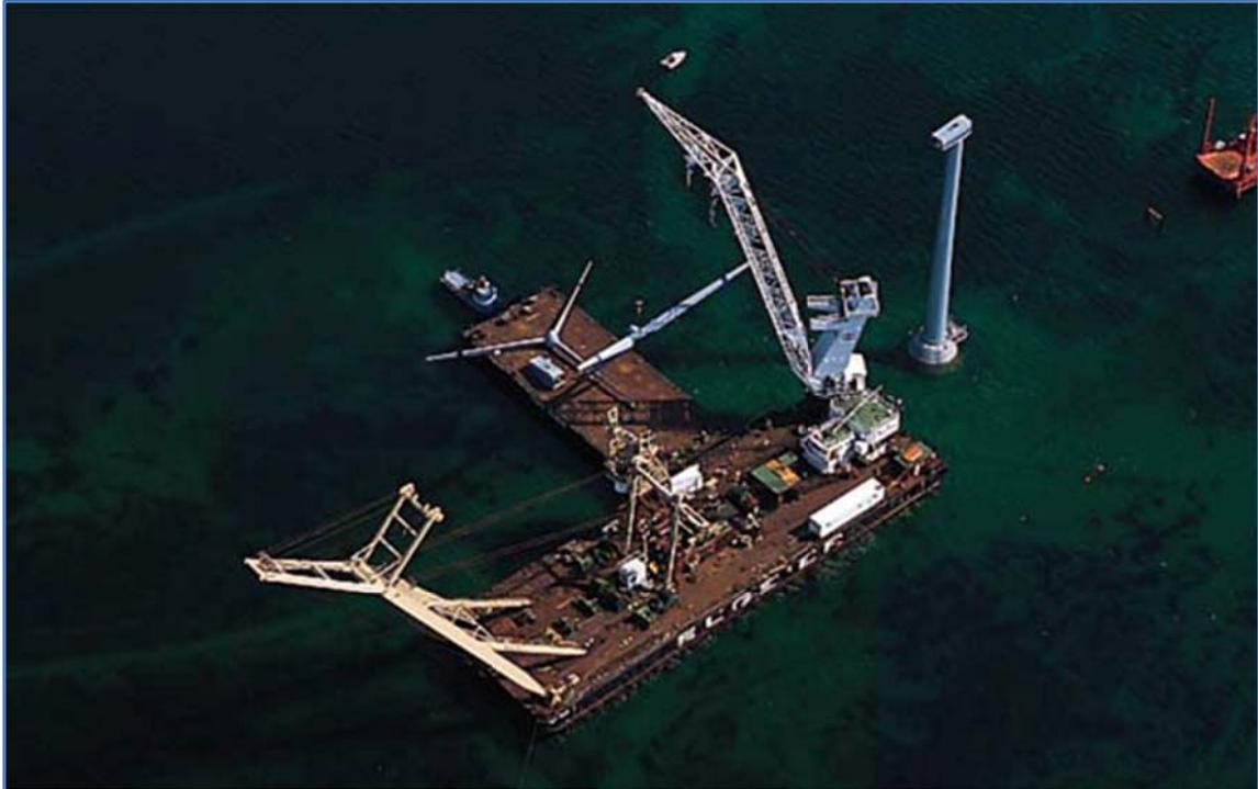
Ilustración 2. Instalación en Tunø (Dinamarca) mediante equipos flotantes. Fuente: [www.motiva.fi](http://www.motiva.fi)
