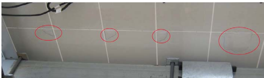
Figura 2.2 - Delaminación en la cara trasera del módulo [3].
