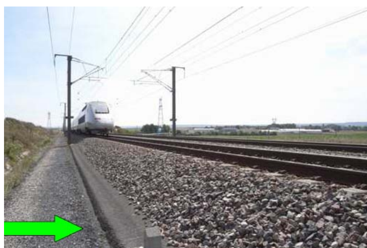
Figura 14: Borde de la capa de subbalasto bituminoso en el tramo de la LGV Est (Fuente: SNCF)
