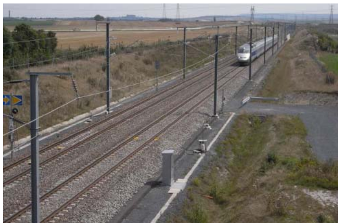
Figura 21: Vista general de la zona instrumentada en servicio (Fuente: SNCF)
