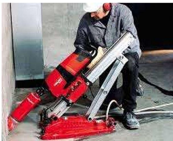
*Figura 4.2. Sistemas de perforación, para ventilación de la cámara sanitaria y permitir la salida del Gas Radón concentrado en su interior.*
