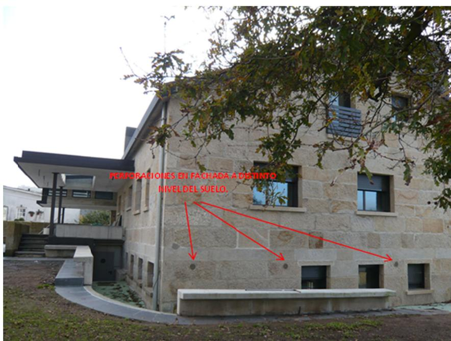
*Figura 4.3. Ventilación natural en fachada Norte.*
