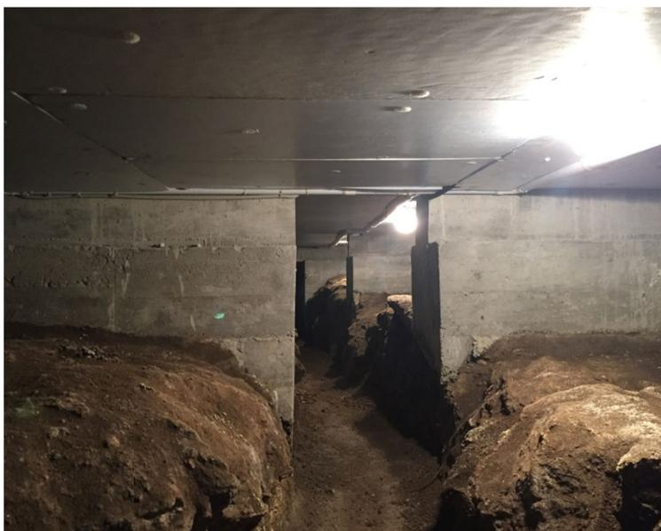
*Figura 4.1. Aislamiento de forjado sanitario con planchas de poliestireno extruido.*
