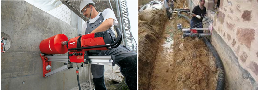
Figura 5.3. Ejemplos de perforación a distinto nivel en horizontal.
