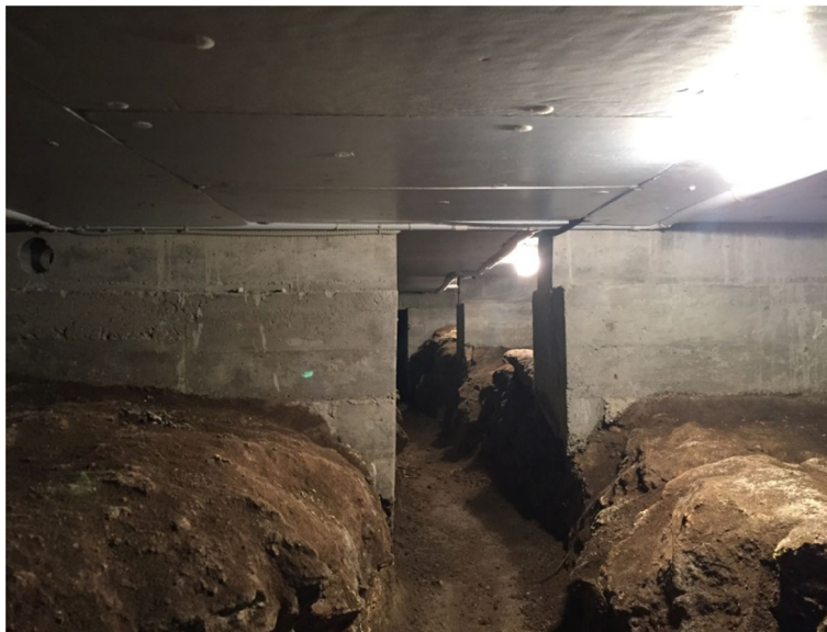
Figura 5.2. Aislamiento con planchas de poliestireno extruido pegadas a techo sanitario.
