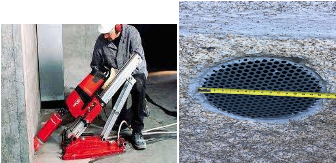
Figura 5.1. Maquinaria de perforación para realizar ventilaciones a través de la fachada y perforación inclinada hacia la cámara bajo el forjado sanitario.
