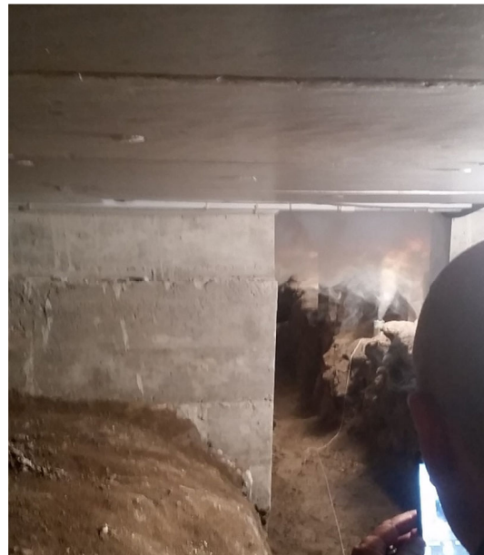
Figura 5.5 Bote de humo activado al interior de cámara sanitaria.
