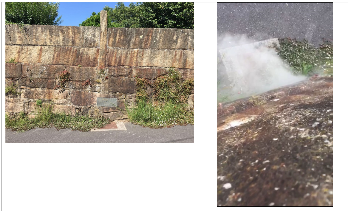
Figura 5.8. Rejilla ubicada al final de la galería y salida de humo.
