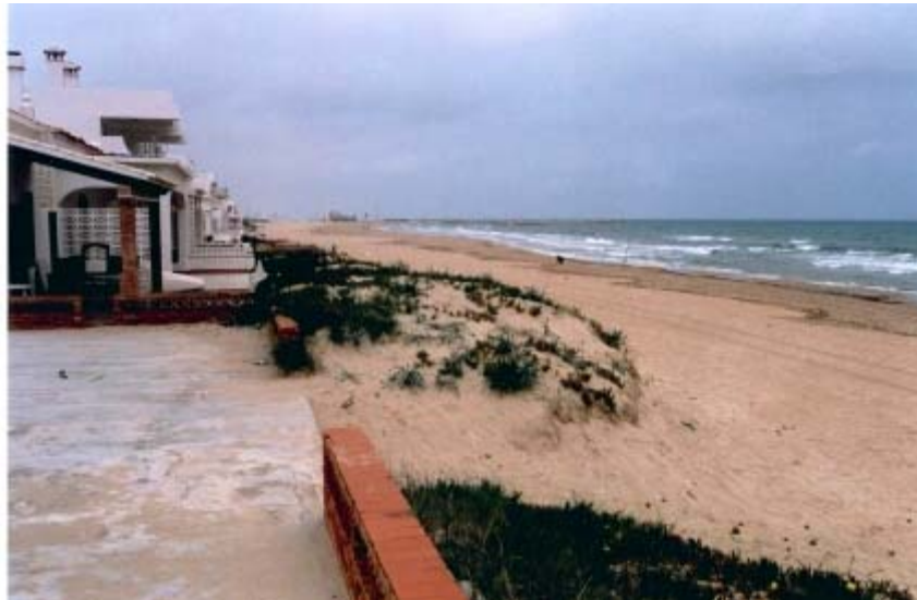
Figura 1. Duna artificial del cordón lateral. La causa de su generación ha sido una edificación de “primera línea de playa”.
