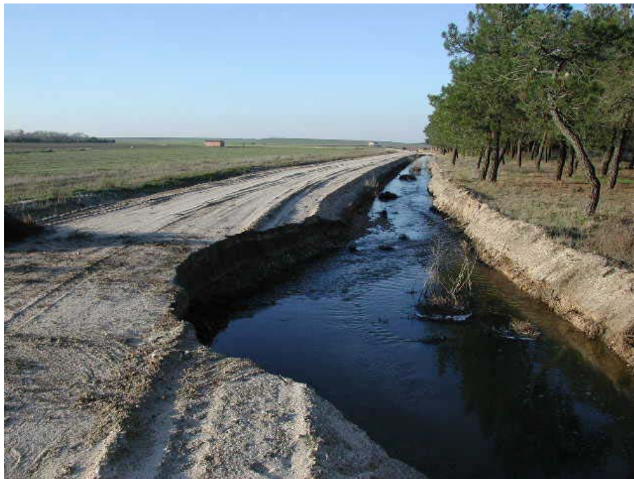
Figura 2. Caz de recarga artificial en la cubeta de Santiuste (Fdez. Escalante, 2005)
