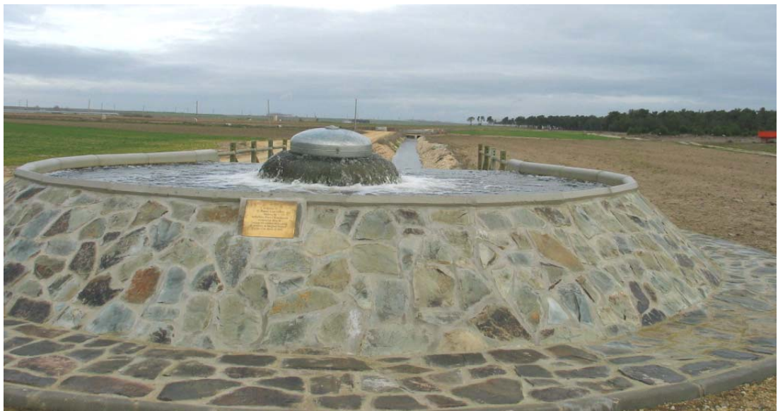
Figura 5. Cabecera del dispositivo de recarga artificial. Diseño inicial a evaluar.
