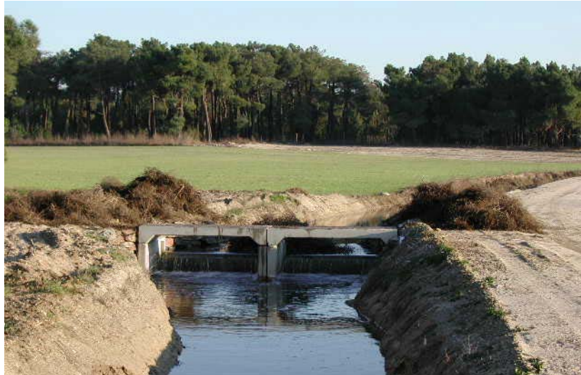
Figura 6. Operaciones de limpieza y mantenimiento del caz de recarga artificial de la Cubeta de Santiuste. Dispositivo de “parada”.
