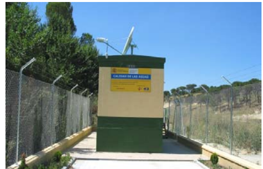
Figuras 2 y 3. Ejemplo de Estación del Sistema automático de Información de la Calidad de las Aguas (SAICA) A-70, río Eresma en Villeguillo.
