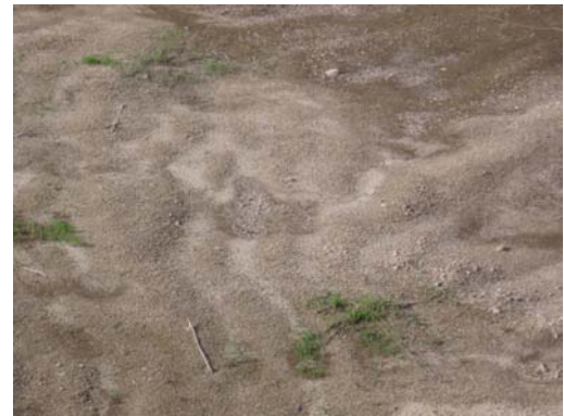
Figuras 1 a) y b). Aspecto del fondo de una balsa de infiltración con generación de procesos colmatantes (bioclogging).
