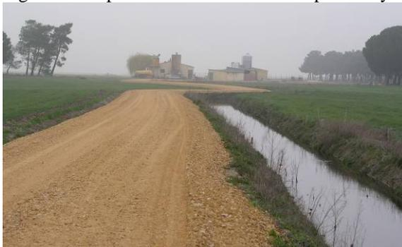
Figura 17. Ejemplo de impactos inherentes a la construcción de la estructura de recarga artificial. Removilización del terreno, tránsito de maquinaria pesada, introducción de elementos extraños, polvo, ruido, afección a la vegetación, etc.
