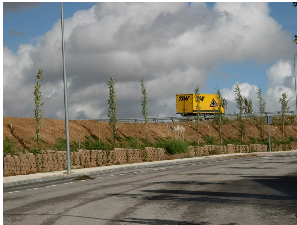
Figura 10: Diques de tierra
