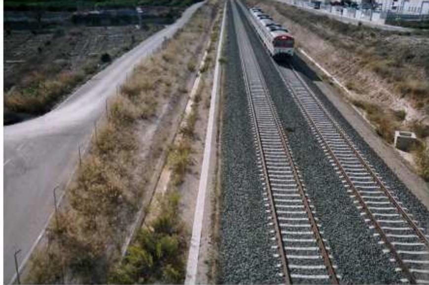
Fig. 18 Vista general de la vía donde se aprecia la alineación de la canaleta. (Fuente: elaboración propia).
