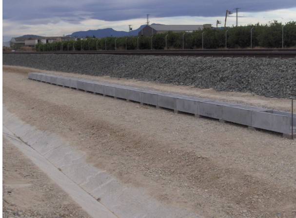
Fig. 16 Tramo de canaleta terminado (Fuente: elaboración propia).
