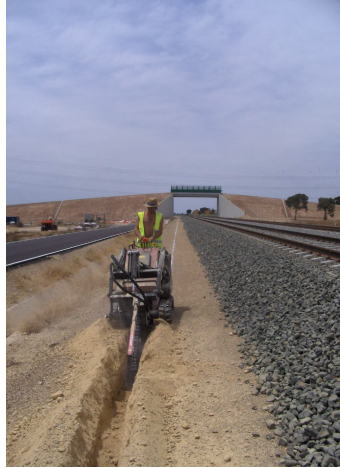
Fig. 12. Corte al borde de la capa de forma ((Fuente: elaboración propia).
