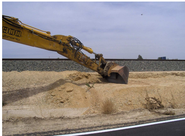
Fig. 13 Retirada del material sobrante (Fuente: elaboración propia).
