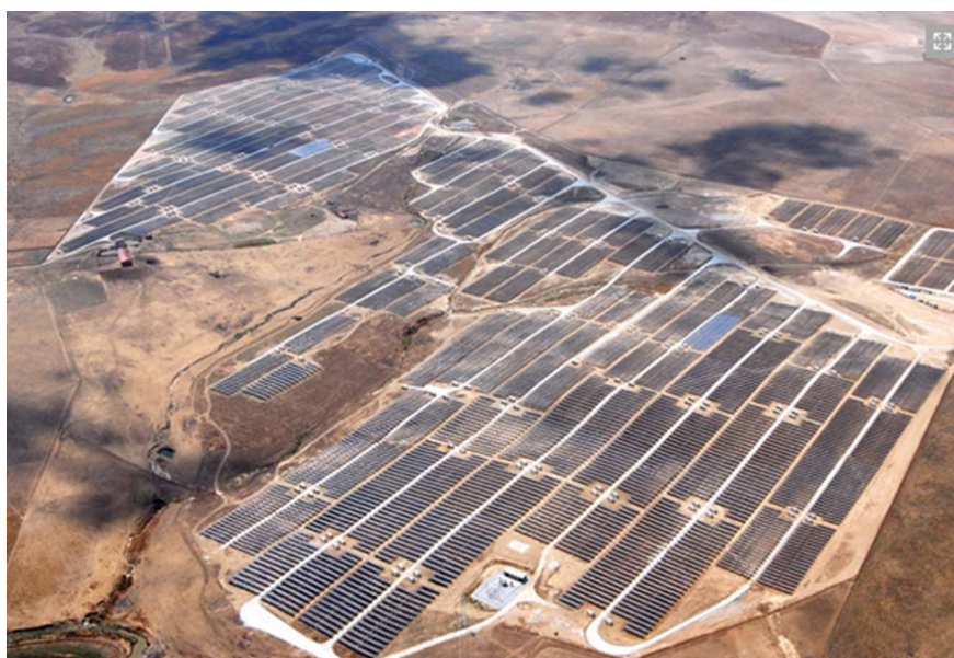
Fig 2.8. Foto del SFCR de 23.300 kWp en Magascona, Cáceres
