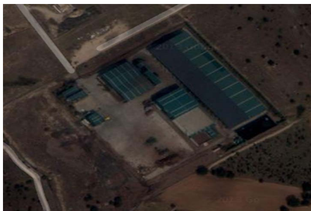
Fig 2.7. SFCR de 500 kW p en Villanueva de la Cañada, Madrid
