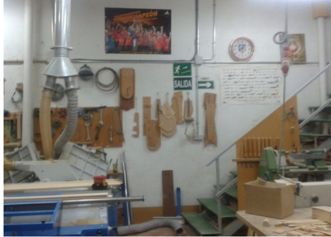
Figura 2.1: Detalle de una de las paredes laterales del taller con acabado en yeso. También se puede apreciar parte del suelo de terrazo y parte de la escalera metálica que conduce a la calle.
