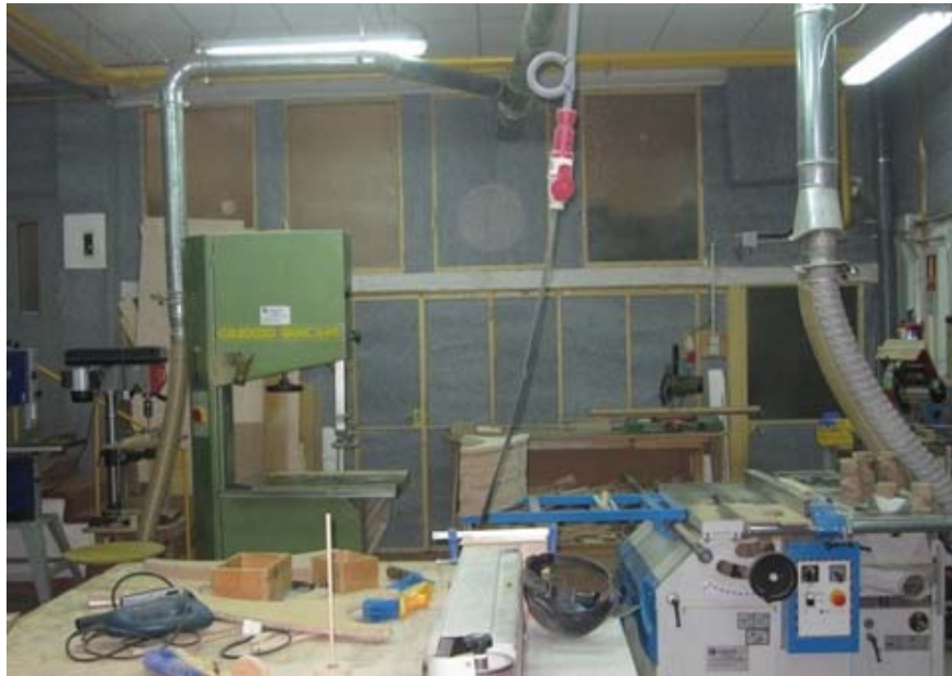
Figura 3.3: Detalle del taller de ebanistería donde se puede apreciar una de las paredes laterales acondicionada por completo con Acustifiber y parte del techo acondicionado con Acustec.
